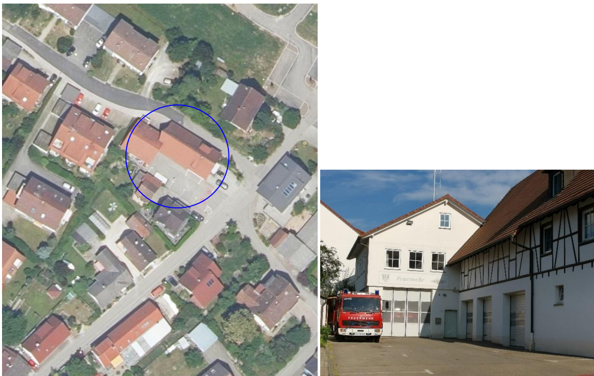
Abb. 6: derzeitiger Standort des Gerätehauses Ludwigshafen in beengter Ortslage in der Schorenstraße (LUBW)
