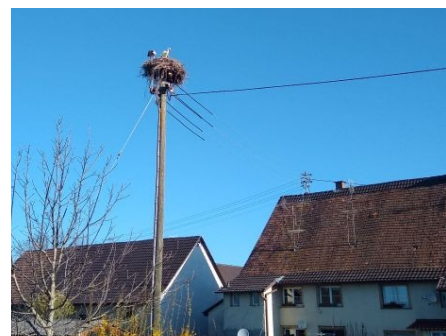
Abb. 6: Strommast mit belegtem Storchennest auf Flurstück Nr. 30 sowie im Hintergrund (rechts) der Gebäudealtbestand auf Flurstück Nr. 29. Blick aus südöstlicher Richtung.
